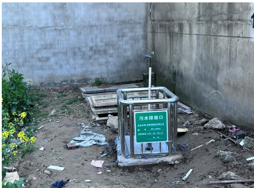
图 3-6 污水排口照片
