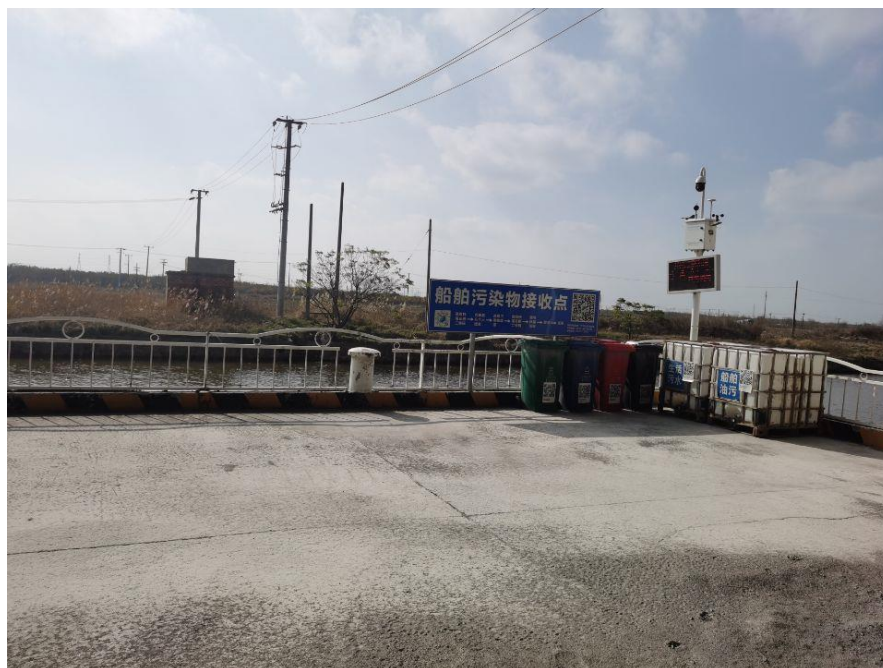
图 4-3 码头前沿挡水坎照片
