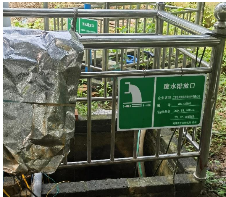
图 3-6 污水排口照片
